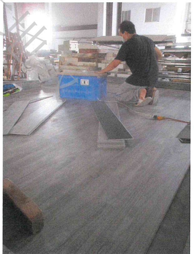
照片 4 試驗件組裝過程(石塑地板鋪設)
