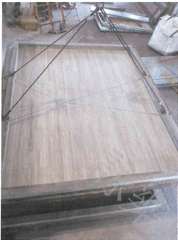
照片 5 試驗件施工完成正面
