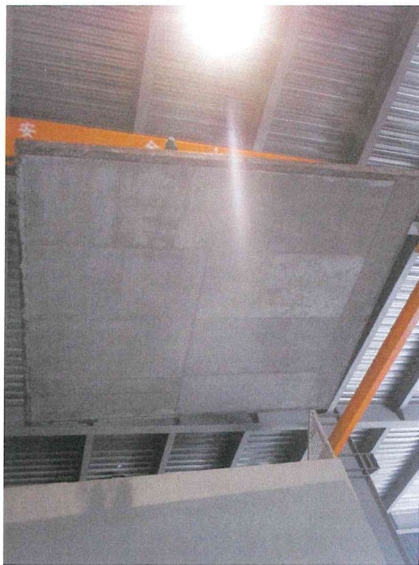
照片 6 試驗件施工完成背面
