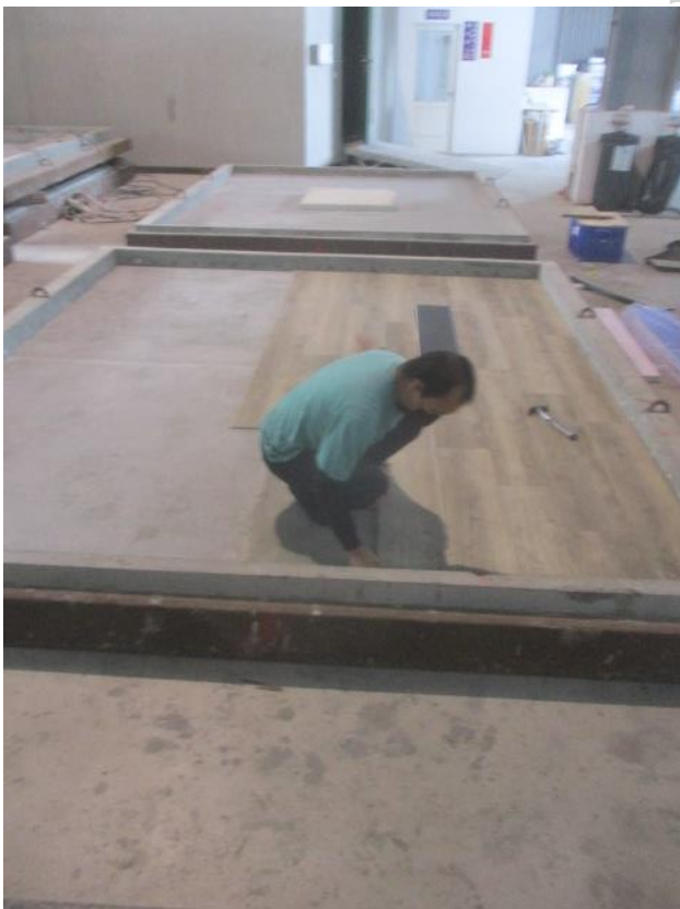
照片 3 試驗件組裝過程(鋪設 SPC 地板)
