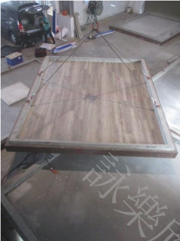
照片 5 試驗件施工完成正面
