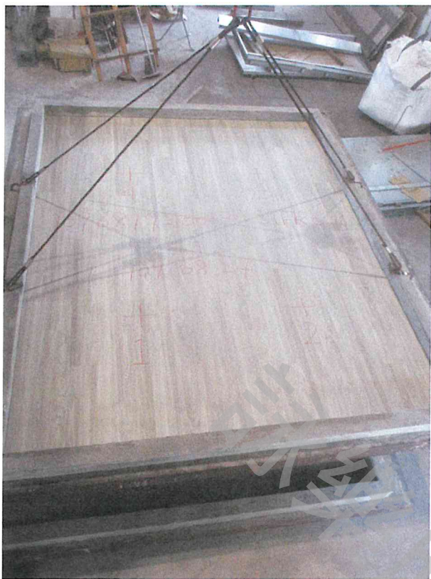
照片 5 試驗件施工完成正面
