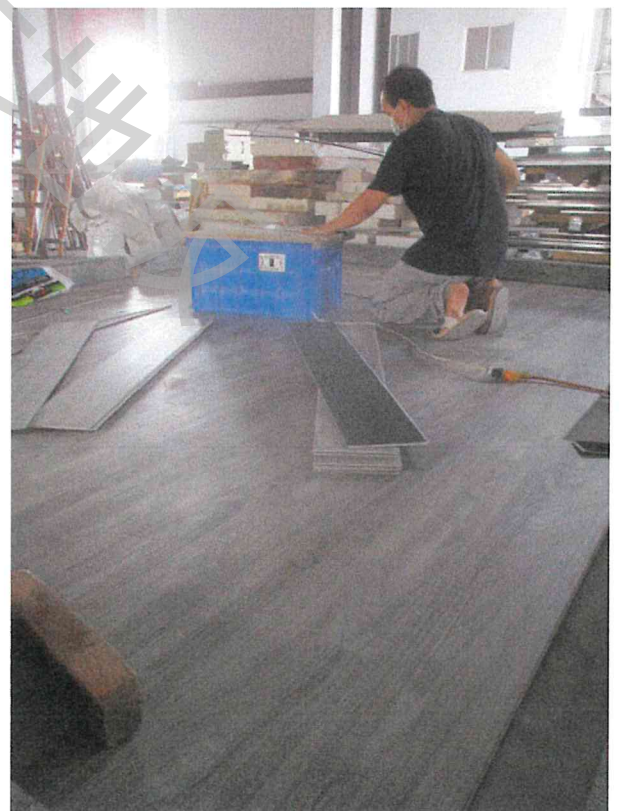
照片 4 試驗件組裝過程(石塑地板鋪設)
