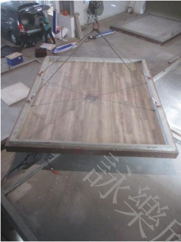
照片 5 試驗件施工完成正面
