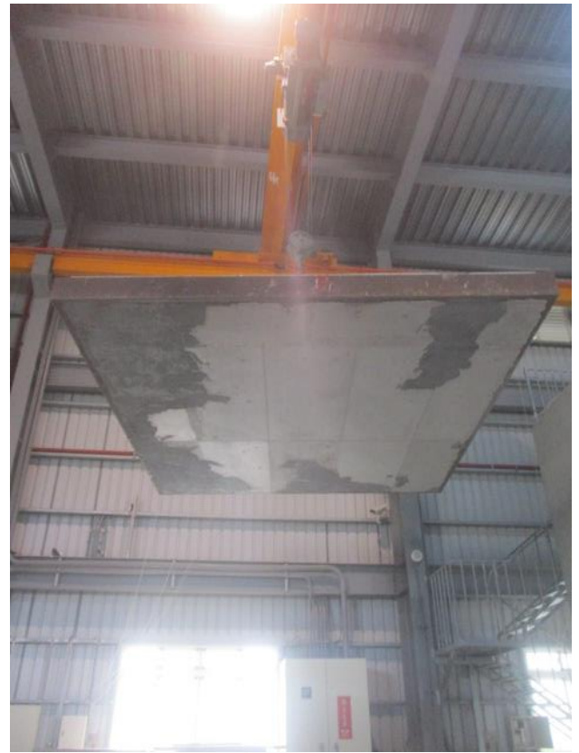
照片 6 試驗件施工完成背面
