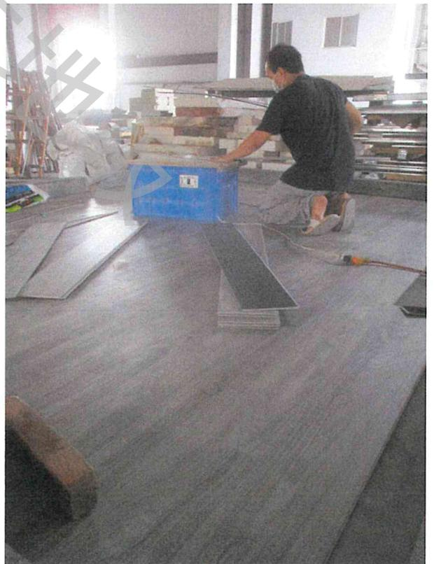
照片 4 試驗件組裝過程(石塑地板鋪設)
